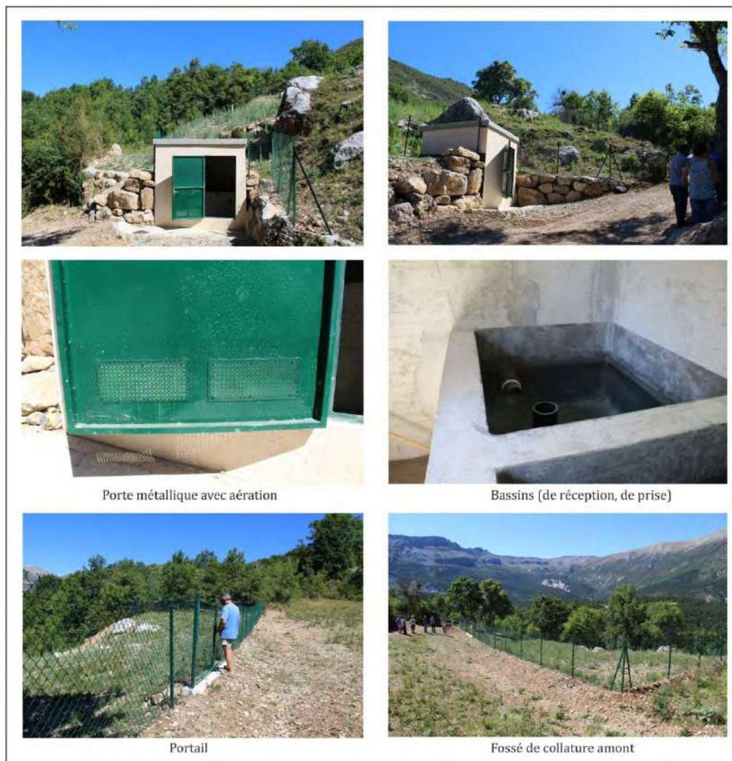
**Figure 3 : Captage de la source des Ferrayes**
